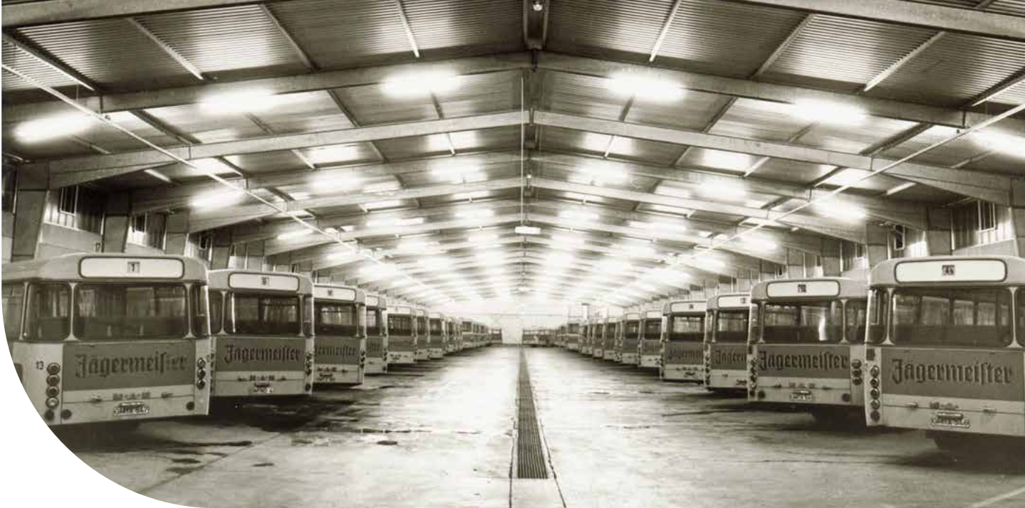
1975 wird die Halle 2 fertiggestellt.
