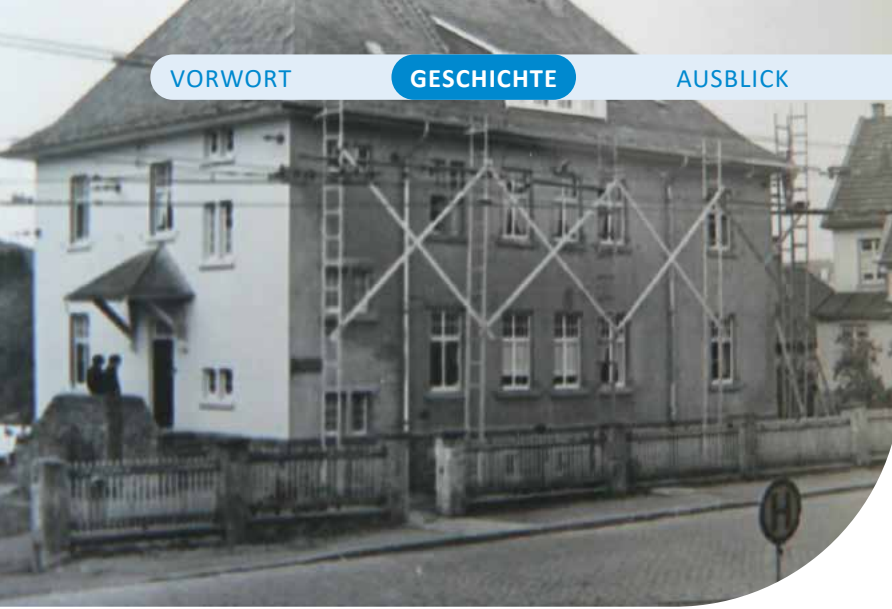
Das 1914 für die Gummersbacher Kleinbahnen errichtete Gebäude ist noch heute Verwaltungssitz der OVAG.
