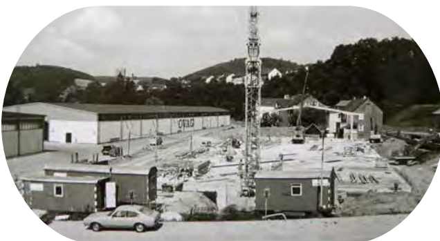
Halle 3 wird in den Jahren 1976 bis 1978 gebaut.
