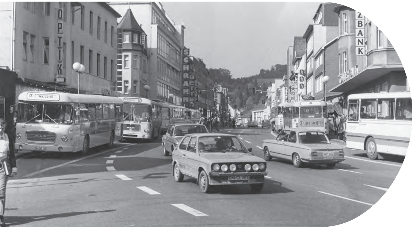
Bushaltebuchten auf der Hindenburgstraße. Nachdem der alte Busbahnhof am Bismarckplatz dem Neubau des Rathauses Anfang der 1980er Jahre weichen musste, hielten hier die Busse, bis der neue (inzwischen auch ersetzte) Busbahnhof 1988 errichtet wurde.
